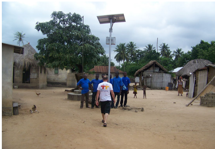
Vérification des panneaux photovoltaïques, Yobo, Togo.
