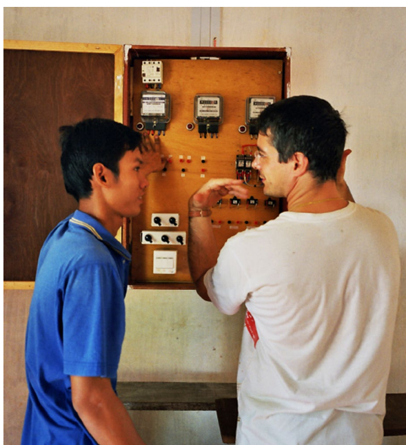
Conseils sur le câblage d'un tableau électrique, Phnom-Penh, Cambodge.
