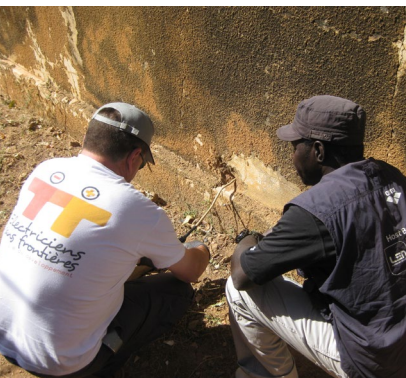
Vérification électrique, Saponé, Burkina Faso.
