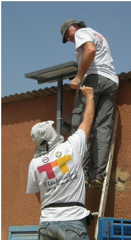
Montage de panneaux solaires, Burkina Faso.
