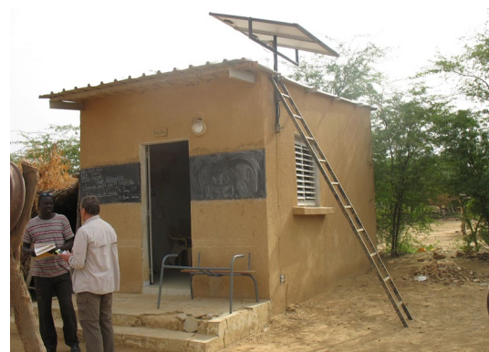
Évaluation des installations, Mboyo, Sénégal.
