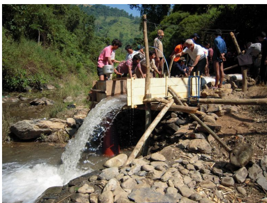
Installation d'une pico turbine, Phongsaly, Laos.
