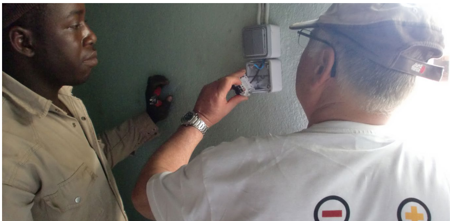
Vérification des installations, Gomponsom, Mali.
